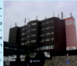
Mobilfunkmaste auf Wohnhaus
